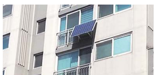
태양광 미니발전소(거치형)가 아파트에 설치된 모습. 동작구청 제공
